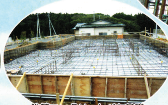
鉄筋コンクリートベタ基礎
